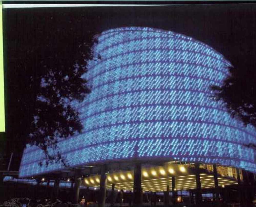
昨年開かれた台北国際エキスポのハビリオン「エコアーク」には約150万個の「ポリ・ブリックス」を使用。このハビリオンは台湾アーバン・ランドスケープ・アワードを受賞した。 Approximately 1.5 million Polli-Bricks were used in the EcoArk Pavilion at the Taipei Expo held last year. The pavilion won the Taiwan Urban Landscape Award.
